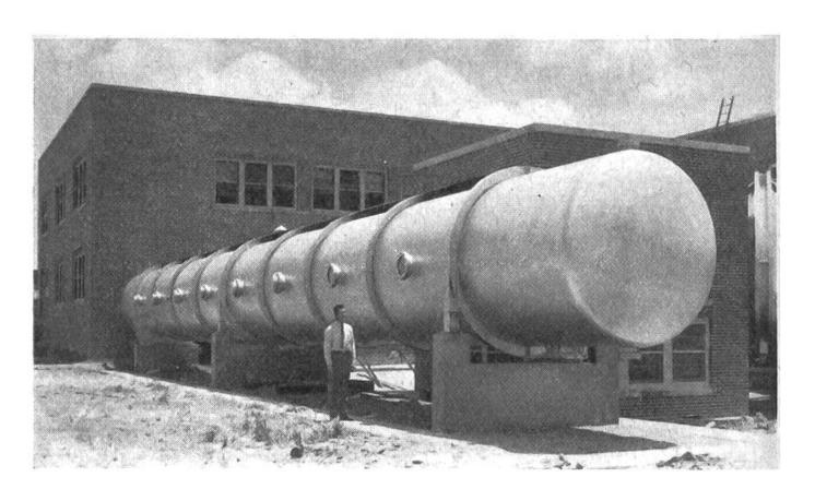
Ein Windkanal, in dem kleine Flugzeugmodelle mit siebenfacher Schallgeschwindigkeit angeblasen werden können.
