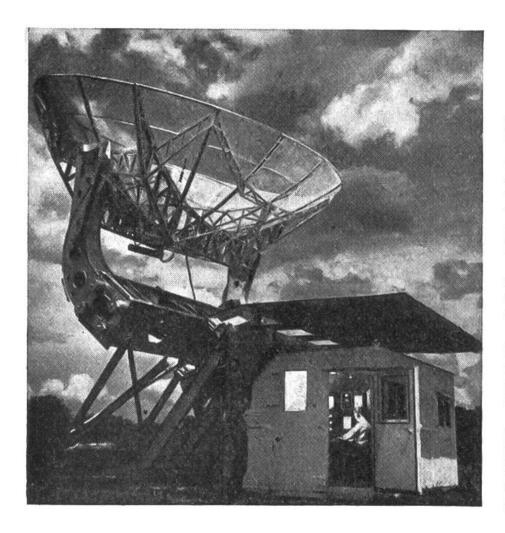
Radioteleskop des "National Bureau of Standards" der Vereinigten Staaten von Nordamerika in Sterling. Dergrosse Reflektor sammelt die elektrischen Wellen aus einem engen
