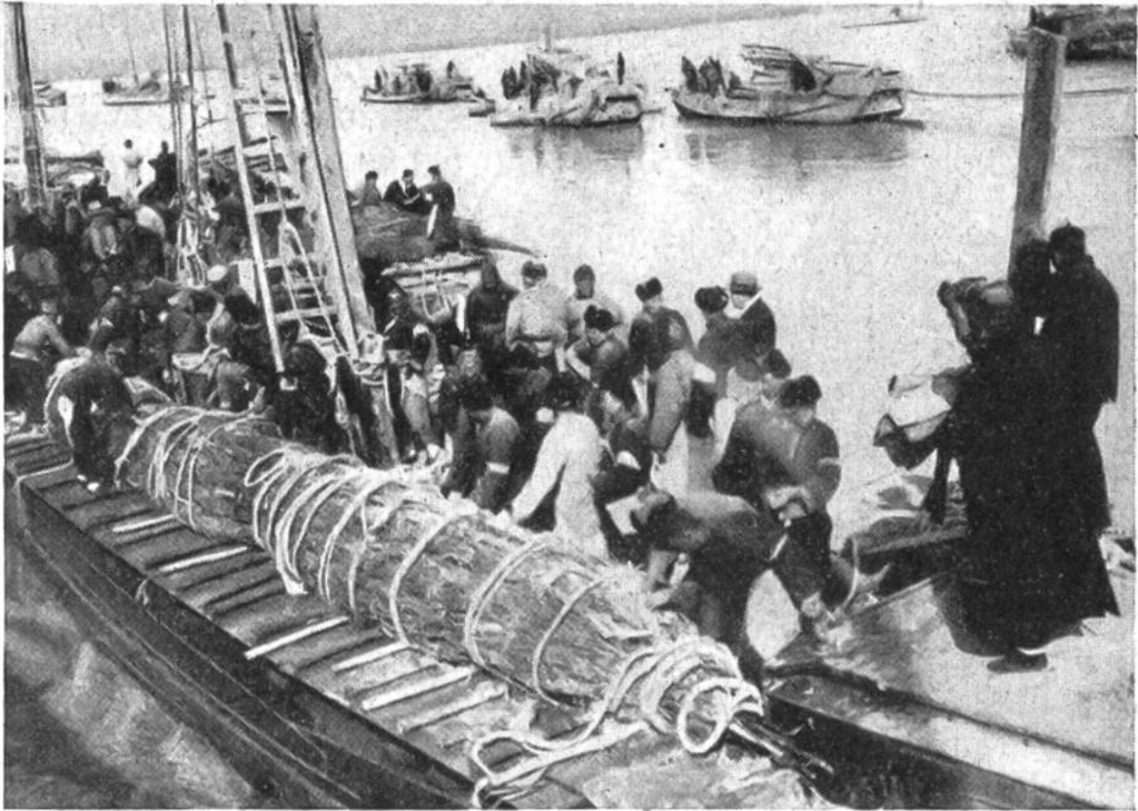
Staubündel aus Holz werden vorbereitet, um die Fluten des Hoangho einzudämmen.
