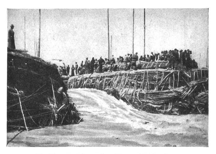
Ein Wasserlauf des Gelben Flusses ist hier eingedämmt und verengt. Man erkennt die Vertauungen und Verstrebungen, die das Deichgefüge zusammenhalten.
