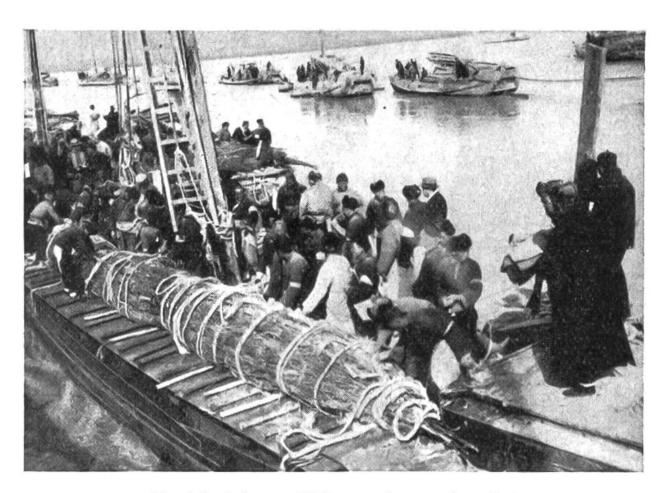
Staubündel aus Holz werden vorbereitet, um die Fluten des Hoangho einzudämmen.
