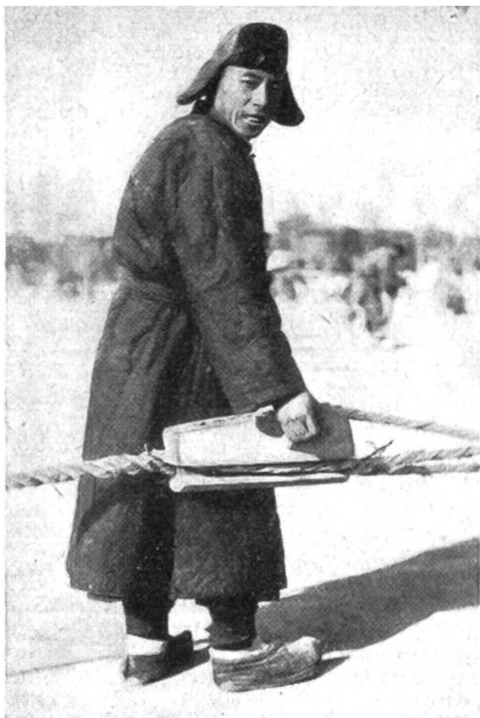
Die starken T a u e, welche die Massen des Dammes halten und spannen, werden durch eine besondere Vorrichtung miteinander verknüpft.
