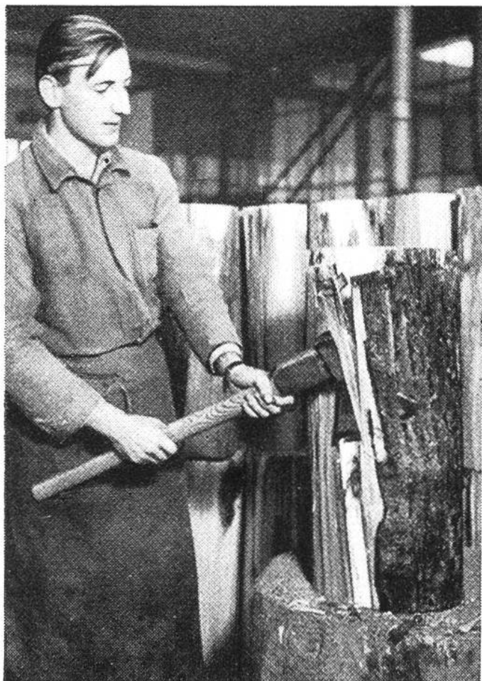
Zum Zwecke der Entharzung werden die Stämme entrindet.
