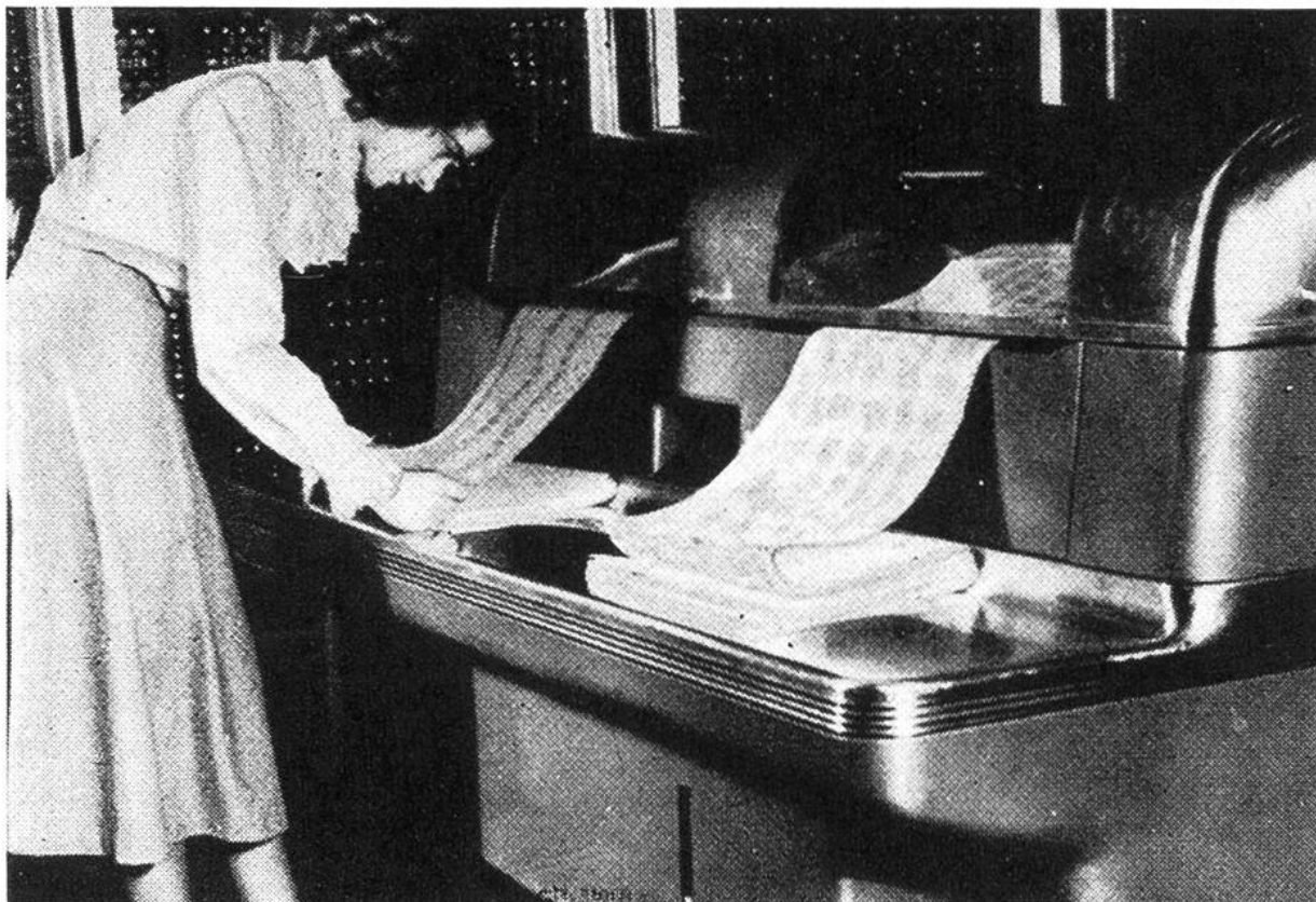
Dieser Apparat schreibt die vorläufigen und die endgültigen Resultate der Rechenoperation nieder.
