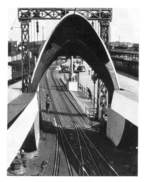
Blick von Bord des Fähreschiffes auf die Verbindungsstelle der festen und schwimmenden Geleise.
