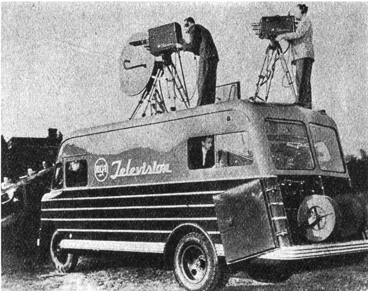
Abb. 5. Bei Aussenaufnahmen wird ein Fernsehswagen benützt, der mit Aufnahmekameras und einem Mikrowellensender ausgestattet ist.
