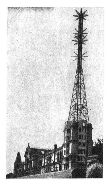
Abb. 6. Der Antennenturm mit der Bild- und Tonsender-Antenne überragt die Londoner Fernsehstation im Alexandra Palace um 100 m.
