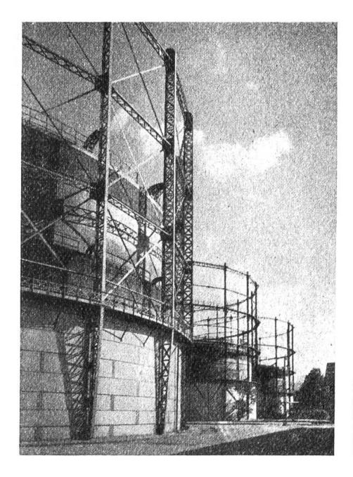
Riesige Gasbehälter von 20000 – 100000 m³ Inhalt speicherndas Gasfür Spitzenbedarf(z. B. über Mittag).
