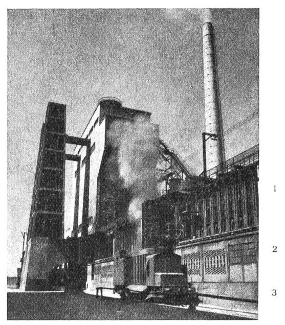
Koks-Ausstoss-Seite der Ofenbatterie. 1 = Ofenbatterie mit Entgasungskammern. 2 = Unterfeuerung für Ofenbatterie. 3 = Koksfüllwagen.
