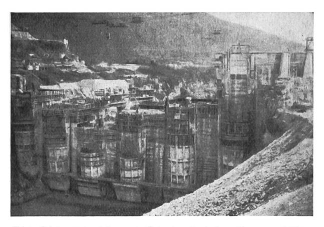
Die Staumauer von Génissiat im Bau, gesehen von der Seite, welche die Rhone stauen wird. 440 000 m³ Beton werden nach Beendigung der Arbeiten das Tal absperren. Die sechs turmähnlichen Gebilde sind die Wassereinläufe zu den Turbinen.
