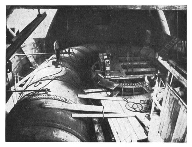
Das Gehäuse der ersten in Betrieb genommenen Turbine. Es ist eine Francis-Turbine mit schneckenförmiger Wasserzuleitung. Sie vermag 120 m³ Wasser in der Sekunde zu schlucken.
