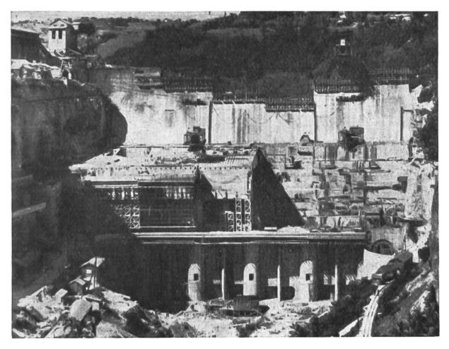
Das ist die Staumauer stromaufwärts gesehen. Dahinter werden 53 Millionen m<sup>3</sup> Wasser gestaut. Das Maschinenhaus, welches Turbinen und Generatoren enthält, ist unmittelbar an die Staumauer angebaut.
