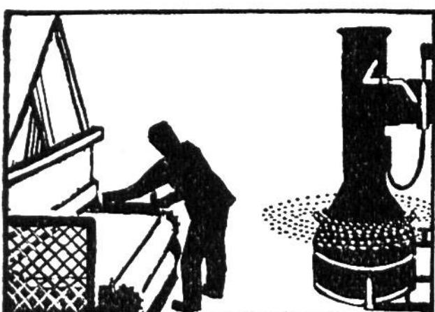
Beim hier abgebildeten Apparat tritt oben Frischluft ein, die in einem Vorwärmer auf eine bestimmte Temperatur gebracht wird; sie strömt dann durch den Luftbefeuchter und wird als ein ständig tätiger, waagrechter Strahlungsfächer ganz fein zerstäubt. Von den zahlreichen Vorteilen einer solchen Anlage für Arbeits- und Lagerräume seien einige erwähnt. Eine gleichmässige Temperatur und Luftfeuchtigkeit in Arbeitssälen hebt Gesundheit, Leistung und Wohlbefinden des Personals.
