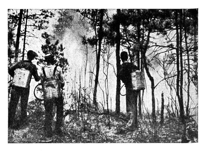
Löscheimer mit Pumpvorrichtung, wie sie bei uns zum Bespritzen der Reben benutzt werden.
