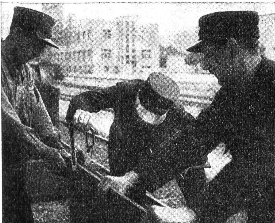
Messen der Dicke von Metallplatten.
