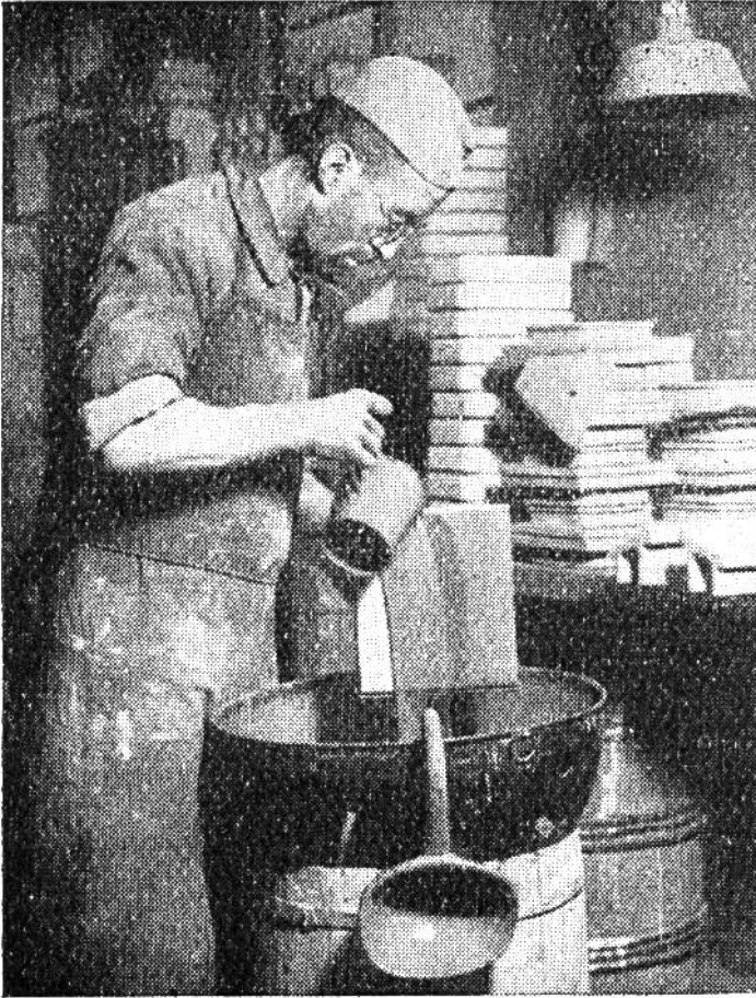
Die Kachel wird mit Glasur übergossen.
