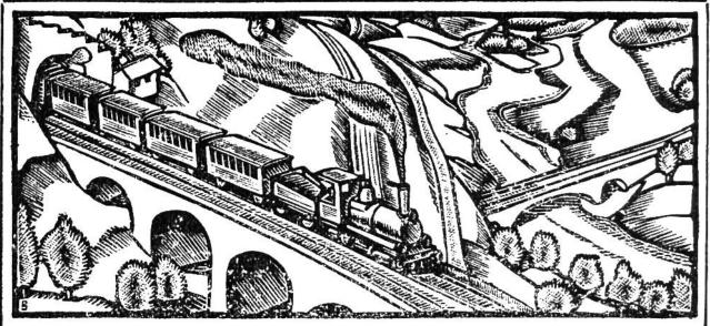
Die 1882 eröffnete Gotthardbahn hat 80 Tunnels und Galerien von zusammen über 46 km Länge und 1234 Brücken und Durchlässe. Sie fährt seit 1920 elektrisch.
