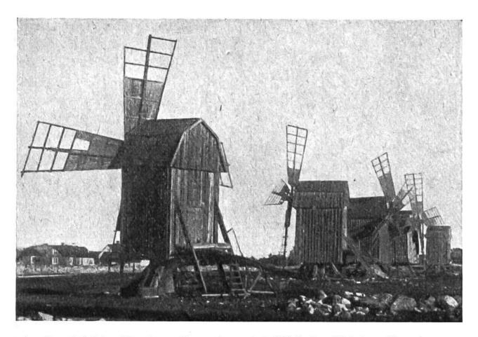
Der leichte Oberbau dieser hauptsächlich in Südskandinavien gebräuchlichen "Bockmühlen" kann über einem hölzernen Bockgerüst nach der jeweiligen Windrichtung gedreht werden.
