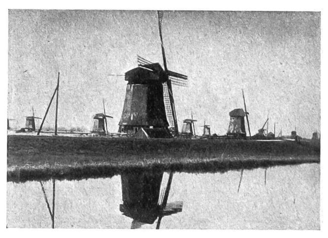
Beim massiven Steinbau der holländischen Windmühle ist nur das hölzerne Dach mit der Radwelle beweglich.
