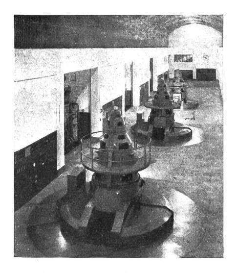
Unterirdische Maschinenhalle des Kraftwerks Innertkirchen. DasWasserdesStausees auf der Grimsel erzeugt in der Zentrale Handeck Elektrizität. Das in den letzten Jahren neu errichtete Kraftwerk Innertkirchen nützt das gleiche Wasser 650 m tiefer nochmals aus.
