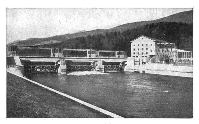
Das Kraftwerk Rupperswil an der Aare ist das neueste Flusskraftwerk der Schweiz. Hinter dem Wehr wird die Aare aufgestaut. Im Maschinenhaus rechts sind zwei Turbinen von je 23 000 PS untergebracht. Daneben ist noch die Umspann- und Schaltstation sichtbar; von dort wird die elektrische Energie durch Freileitungen den Verbrauchern zugeführt.
