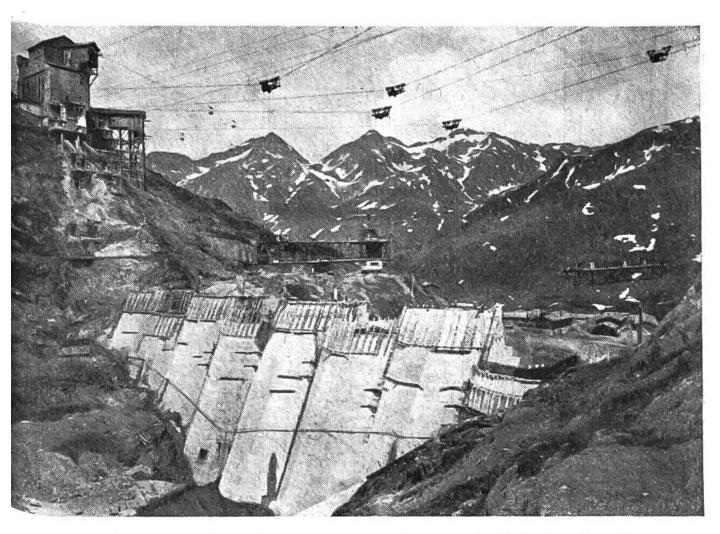
Errichten der Staumauer für das Speicherkraftwerk Lucendro beim Lucendro-See unweit des Gotthard-Hospizes auf 2000 m Höhe. Es konnte nur im Sommer daran gearbeitet werden. Das Material musste mit Hilfe einer Luftseilbahn von Airolo an die Baustelle befördert werden. Die 60 m hohe Staumauer wird 25 Millionen Kubikmeter Wasser aufstauen.
