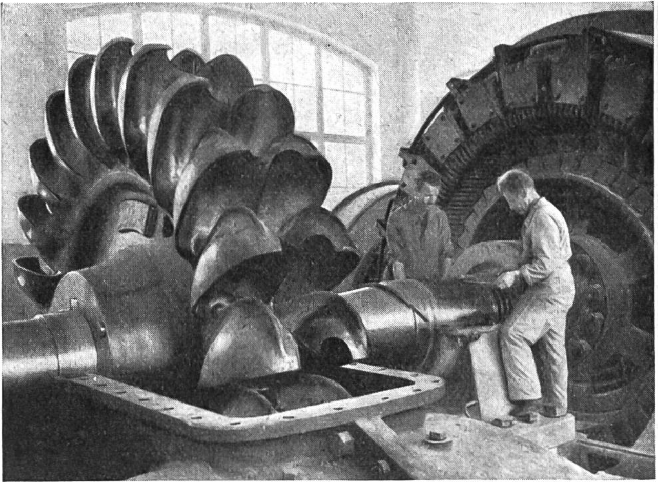
Eine der zwei Pelton-Turbinen mit den mächtigen Schaufeln und der dazu gehörige Generator (Stromerzeuger) im Hochdruck-Speicherkraftwerk Lucendro während des Baus. - Vom Stausee her stürzt das Wasser in einer Druckleitung auf die 930 m tiefer gelegenen Turbinen-Schaukeln der Zentrale Airolo. Diese Turbine schluckt 3 Kubikmeter Wasser in der Sekunde und leistet 33 000 PS.
