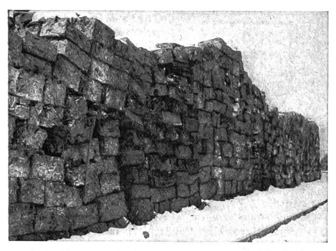
Paketiertes Alteisen. Die gesammelten Abfälle sind in grossen Pressen zu Würfeln zusammengepresst worden, die zu riesigen Mauern aufeinandergetürmt der Verwendung harren.
