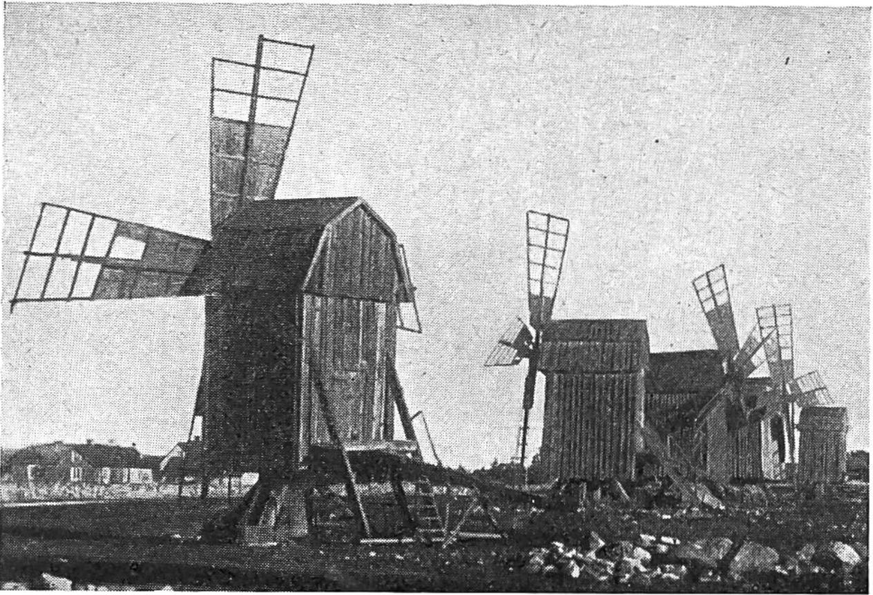
Der leichte Oberbau dieser hauptsächlich in Südkandinavien gebräuchlichen „Bockmühlen“ kann über einem hölzernen Bockgerüst nach der jeweiligen Windrichtung gedreht werden.
