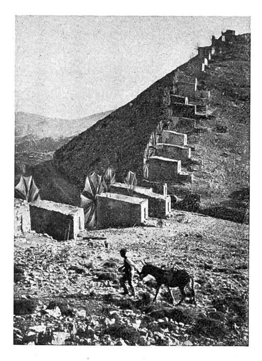
Der "Pass der dreissig Windmühlen" auf der griechischen Insel Kreta. – Die Windmühlen treiben Pumpen, die während des Sommers das trokkene Land mit Wasser versorgen.
