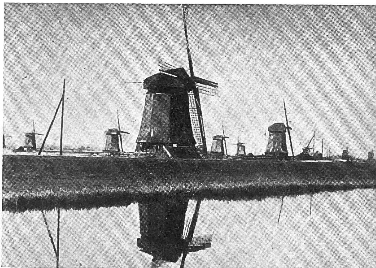
Beim massiven Steinbau der holländischen Windmühle ist nur das hölzerne Dach mit der Radwelle beweglich.
