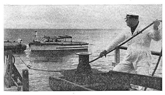
Das Landungsfloss muss je nach dem Wasserstand an verschiedenen Stellen des Laufstegs befestigt werden.
