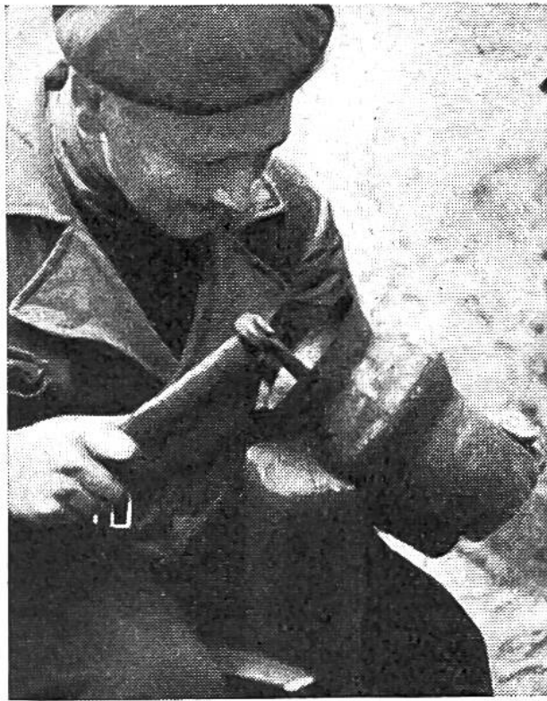
O b e n : Mit einem Holzhammer wird das K u p f e r b l a t t in die gewünschte Form geklopft.
