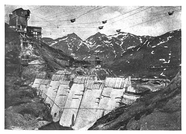
Errichten der Staumauer für das Speicherkraftwerk Lucendro beim Lucendro-See unweit des Gotthard-Hospizes auf 2000 m Höhe. Es konnte nur im Sommer daran gearbeitet werden. Das Material musste mit Hilfe einer Luftseilbahn von Airolo an die Baustelle befördert werden. Die 60 m hohe Staumauer wird 25 Millionen Kubikmeter Wasser aufstauen.
