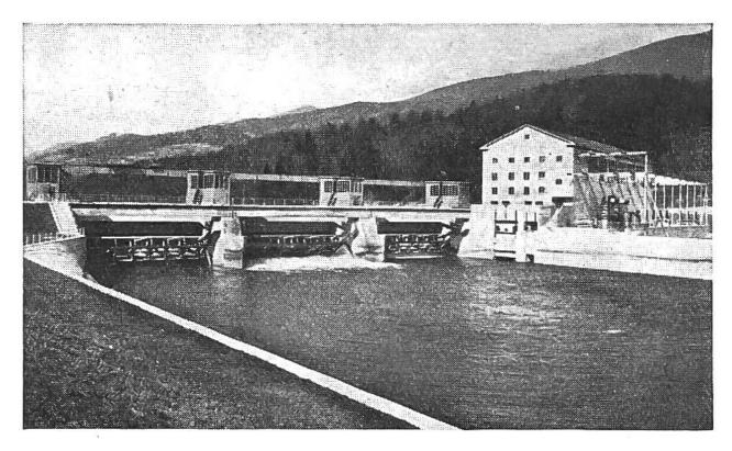
Das Kraftwerk Rupperswil an der Aare ist das neueste Flusskraftwerk der Schweiz. Hinter dem Wehr wird die Aare aufgestaut. Im Maschinenhaus rechts sind zwei Turbinen von je 23 000 PS untergebracht. Daneben ist noch die Umspann- und Schaltstation sichtbar; von dort wird die elektrische Energie durch Freileitungen den Verbrauchern zugeführt.
