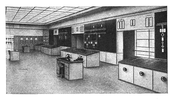
Kommandoraum des Flusskraftwerks Verbois an der Rhone bei Genf. Das seit 1943 in Betrieb stehende Kraftwerk versorgt die Stadt Genf und die Westschweiz mit elektrischer Energie. Vom Kommandoraum aus wird – einzig durch den Druck auf Schaltknöpfe – die Abgabe der Energie von über 94 500 PS geregelt.
