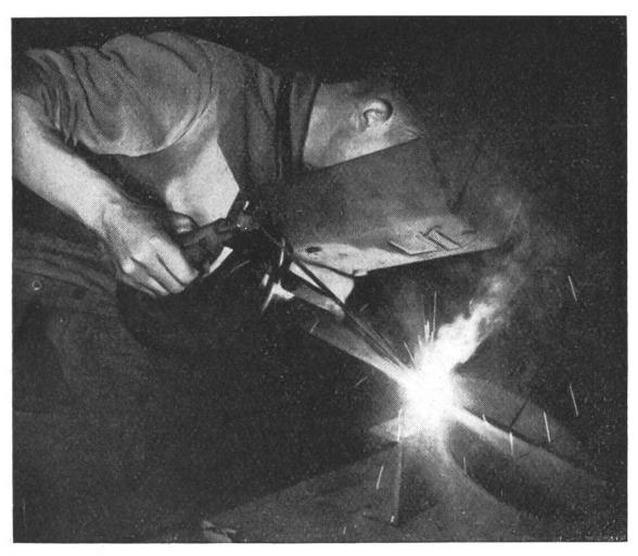
Während des Schweissens schützt der Schlosser sein Gesicht mit einer Abschirm-Vorrichtung. Das eingebaute Fensterchen ermöglicht ihm, die Arbeit mit peinlicher Sorgfalt auszuführen.
