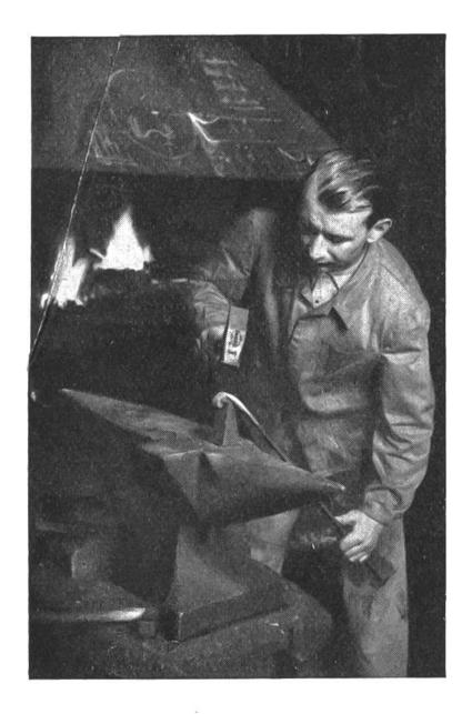
Mit dem schweren Hammer wird das glühende Eisen auf dem Amboss zur gewünschten Form geschmiedet. Gewandtheit und selbständiges Gestalten sind für die Ausübung des Schmiedehandwerks unerlässliche Voraussetzungen.
