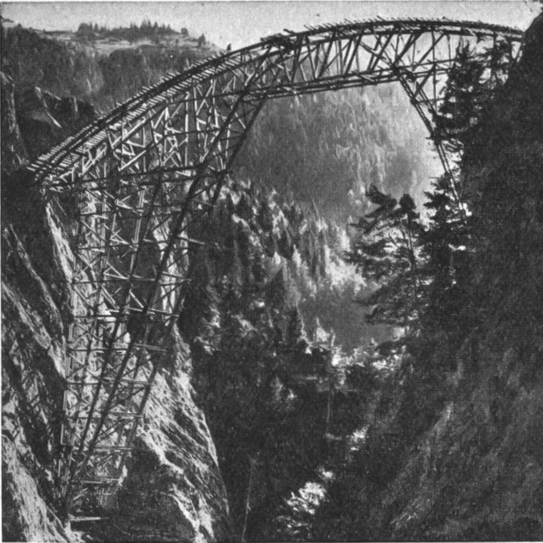
Abb. 6. Gerüst der Salgina-Tobel-Brücke von 90 m Spannweite.
