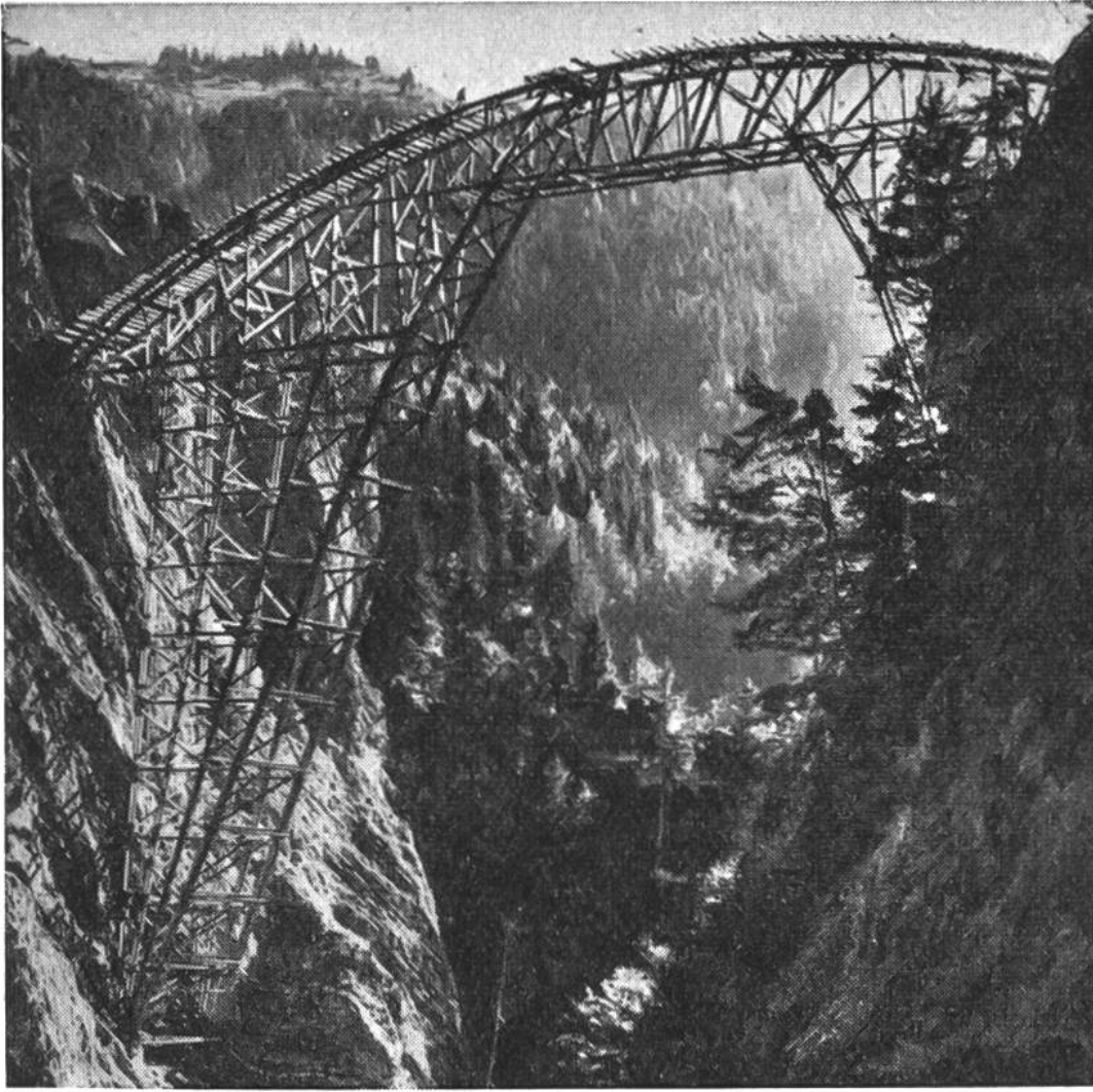
Abb. 6. Gerüst der Salgina-Tobel-Brücke von 90 m Spannweite.
