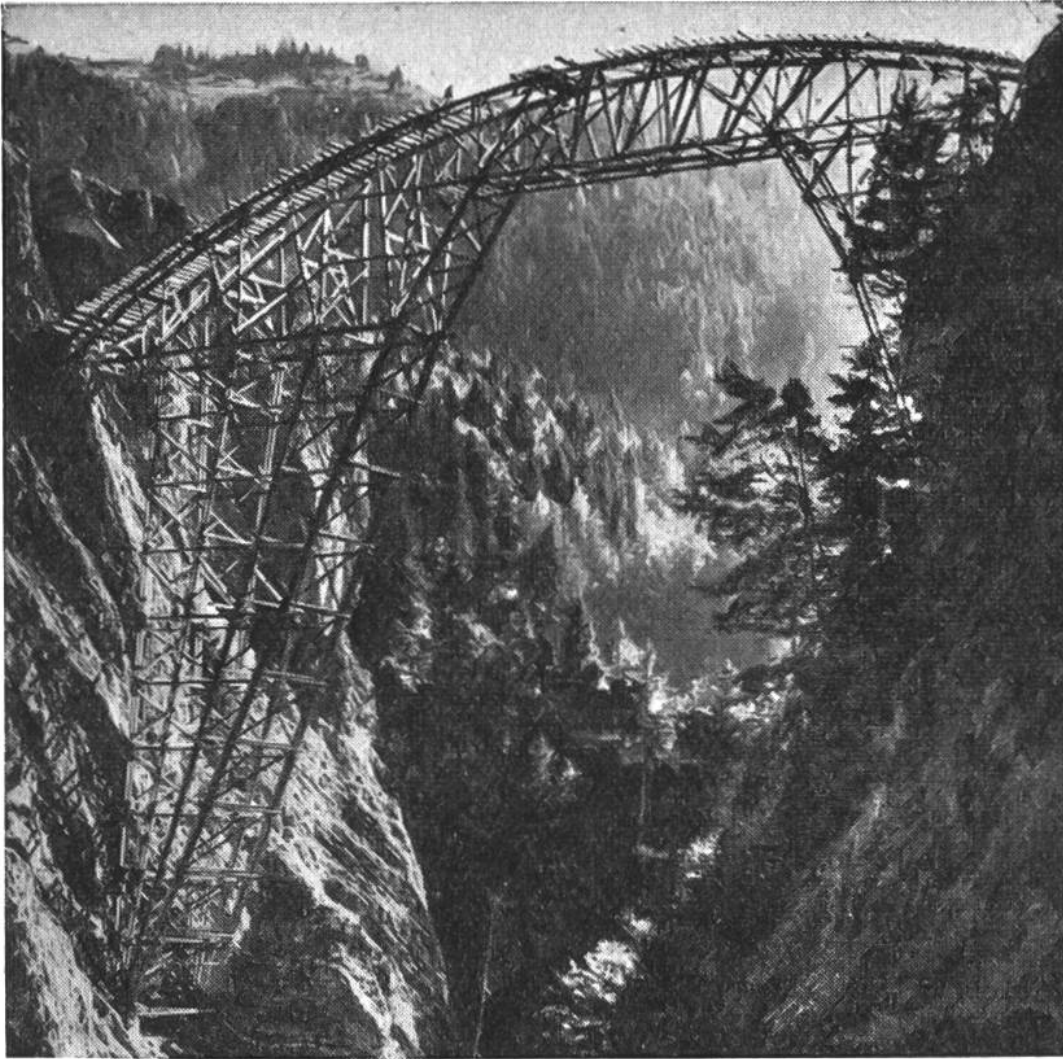
Abb. 6. Gerüst der Salgina-Tobel-Brücke von 90 m Spannweite.
