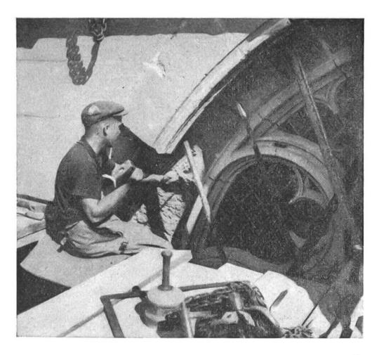
In schwindelnder Höhe wird über dem Chorfenster ein verwittertes Teilstück herausgehämmert, um es dann durch ein neues zu ersetzen.
