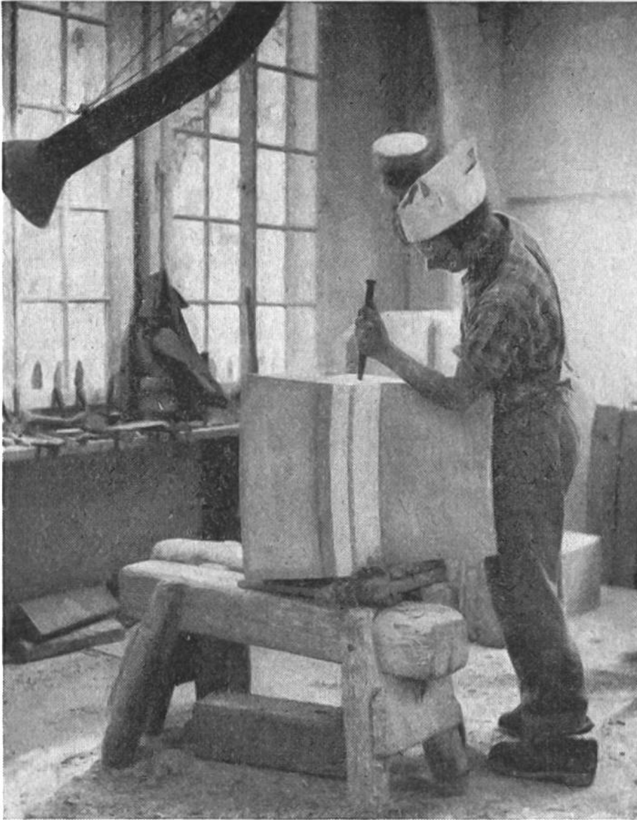
Der Steinmetz meisselt in der Bauhütte ein Ersatzstück eines Spitzbogens.
