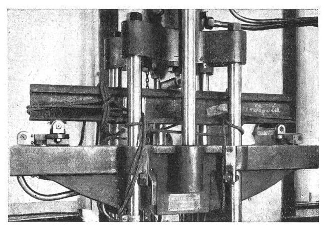
Abb. 7: Prüfung einer Schiene auf Ermüdung im Pulsator.
