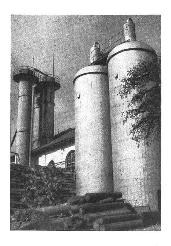
Trockeneisfabrik. Die durch Verbrennen von Kohle oder Holz entstehende Kohlensäure wird in den riesigen Kesseln unter Druck aufgestapelt. Sie weist dort eine Temperatur von minus 30° Celsius auf; die Behälter, die 100 000 kg Kohlensäure fassen, sind zum Schutz gegen äussere Wärmeeinflüsse gut abgedichtet.
