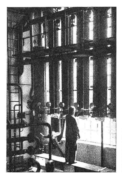
In diese zylinderförmigen Behälter, die Expansionsgefässe, wird flüssige Kohlensäure eingespritzt. Sie entspannt sich darin, u. durch die dabei entstehende grosse Abkühlung bildet sich ein feiner Kohlensäureschnee, der erstarrt, Trockeneis' ergibt.
