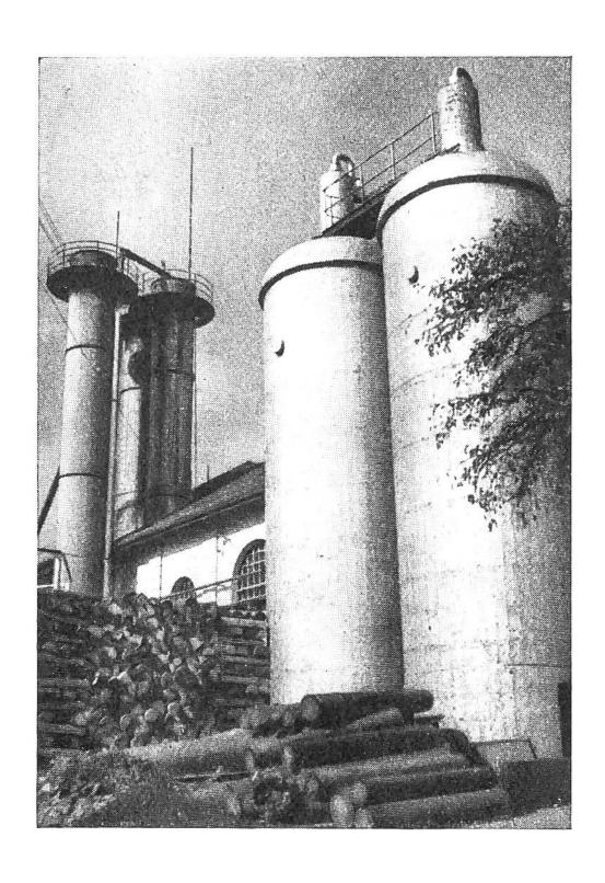
Trockeneisfabrik. Die durch Verbrennen von Kohle oder Holz entstehende Kohlensäure wird in den riesigen Kesseln unter Druck aufgestapelt. Sie weist dort eine Temperatur von minus 30° Celsius auf; die Behälter, die 100 000 kg Kohlensäure fassen, sind zum Schutz gegen äussere Wärmeeinflüsse gut abgedichtet.
