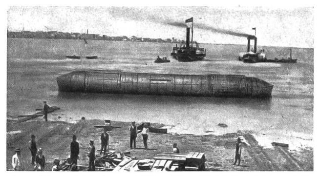
Zum Transport nach London wurde ein Schiffsrumpf um den Obelisk gebaut. Kabinenhaus, Mast und Steuerruder wurden später angebracht. Auf diese Weise verpackt, sollte die "Nadel" noch manches Abenteuer erleben.
