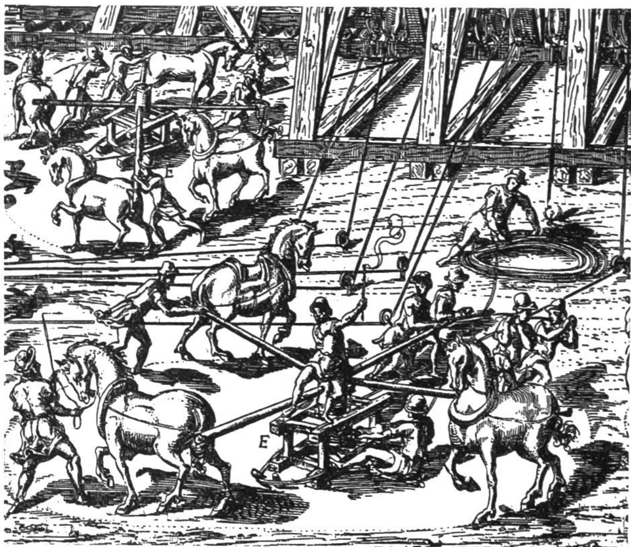
Ausschnitt aus einer zeitgenössischen Darstellung von der Aufrichtung des etwa 480 Tonnen schweren Obeliskens im Jahre 1586 vor der St. Peterskirche in Rom. 800 Mann und 150 Pferde setzten 40 Seilwinden in Betrieb; zwei davon sind auf unserem Bild zu sehen.
