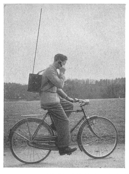
Das tragbare drahtlose Nachrichtengerät hängt wie ein Rucksack am Rükken des Radfahrers und wiegt nur etwa 9 kg. Die antenne ragt senkrecht aus dem Apparatekasten aus; dieser enthält auch zwei Bat-Die Stabterien. antenne
