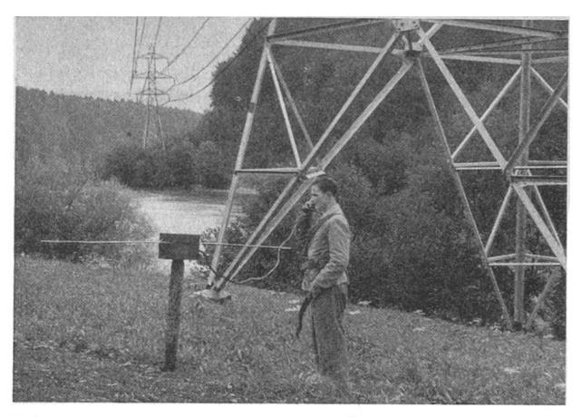
Bei Arbeiten an weitgespannten elektrischen Überlandleitungen leistet das tragbare drahtlose Telephon wertvolle Dienste. Auf unserm Bilde steht der Apparatekasten mit den Antennen auf einem Holzpfahl. Der Monteur kann sich mühelos mit dem Arbeiter bei einem andern Gittermast verständigen.
