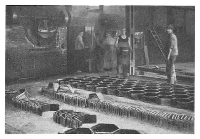
Der dickflüssige, heisse Asphaltbrei wird in sechseckige Formen gegossen, in denen man ihn erkalten lässt.
