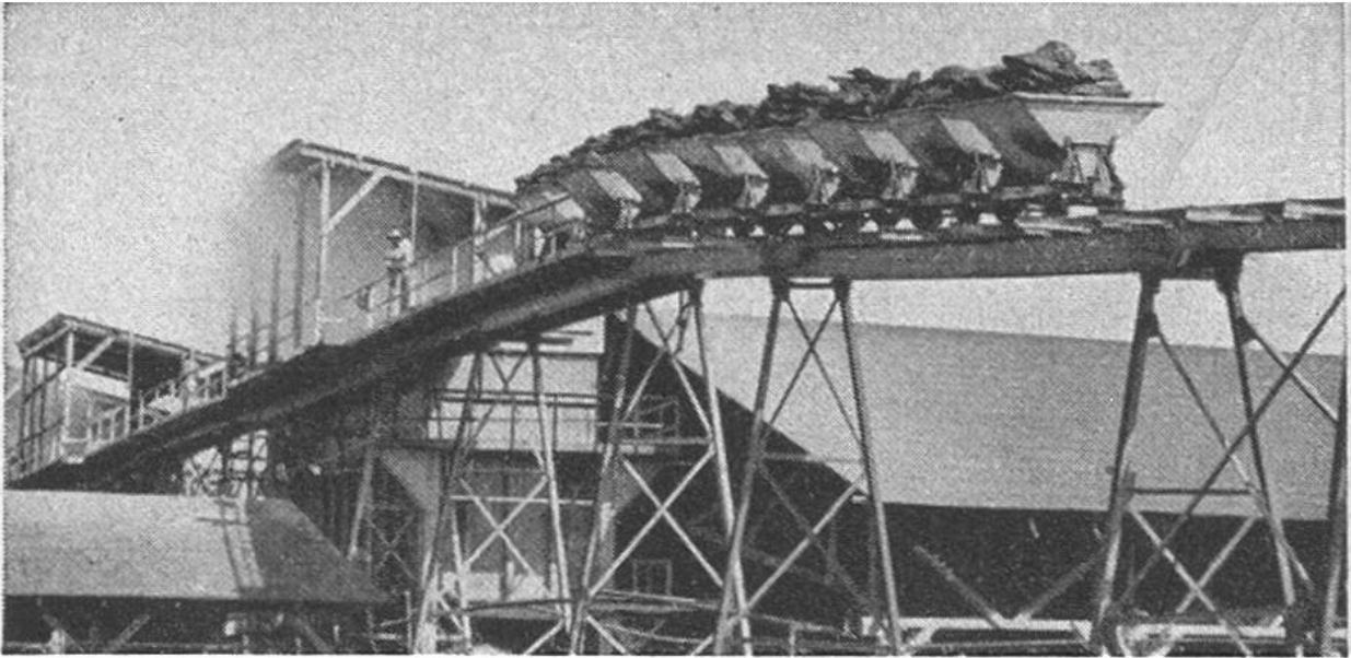
Die Wagen fahren vollbeladen mit ihrer kostbaren Asphaltlast zu Fabrik und Lagerhäusern.
