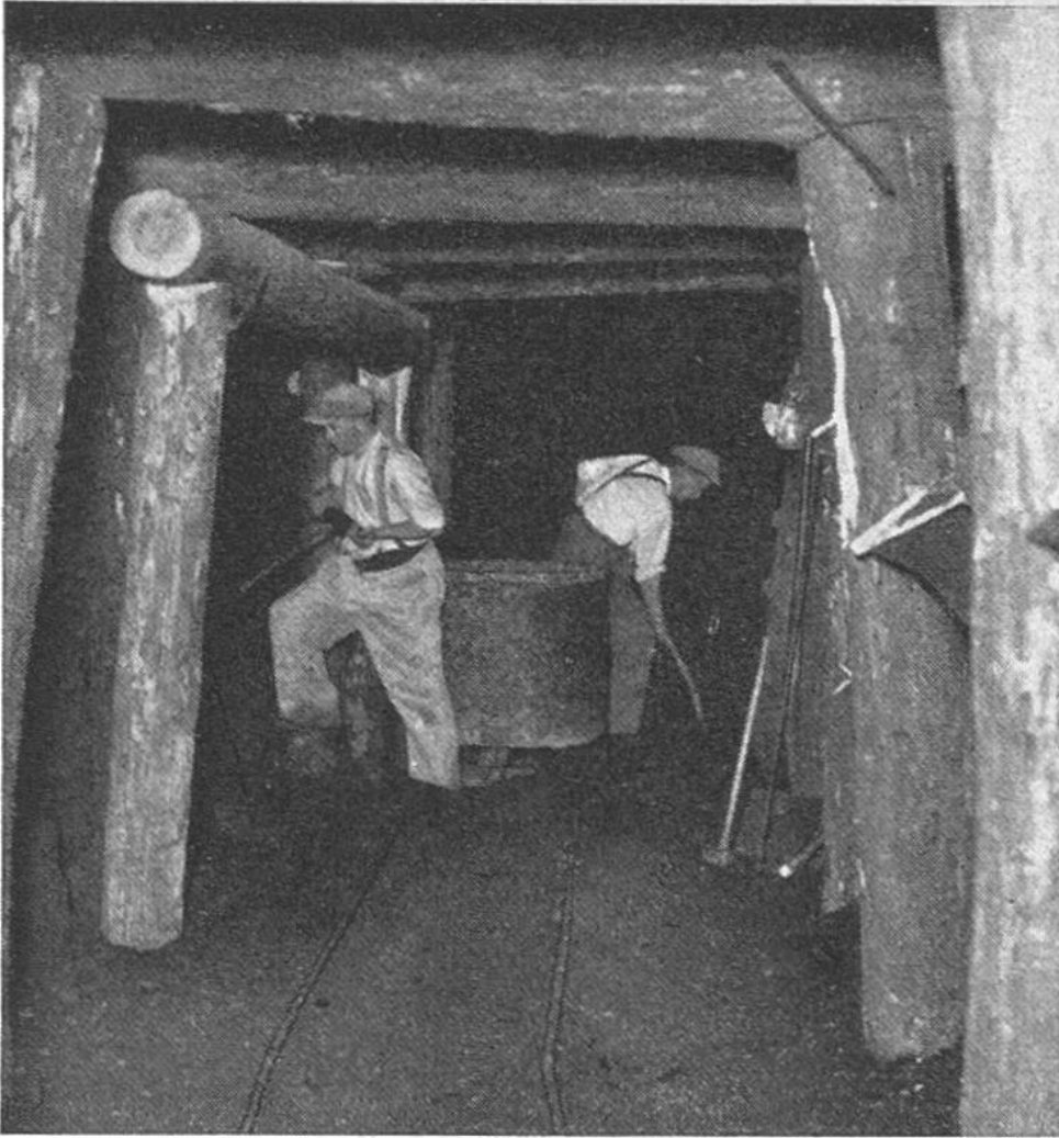
Blick in das Asphalt-Bergwerk im Val de Travers. Geschützt durch ein Holzgerüst, bohren einige Arbeiter Sprenglöcher in das Gestein, andere verladen die noch von der letzten Sprengung herumliegenden Brocken in die bereitstehenden Rollwägelchen.
