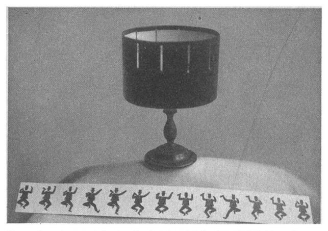
Das Zootrop oder "Lebensrad", das 1832 in Amerika erfunden wurde. Der Papierstreifen wird so in den Hohlzylinder gestellt, dass die Zeichnung mit der in verschiedenen Bewegungen dargestellten Figur nach innen sieht. Versetzt man die Trommel in rasche Drehung und schaut schräg abwärts durch eine der schmalen Öffnungen, so scheint sich die Figur auf dem Papierstreifen zu bewegen; eine überraschende Wirkung! Das Auge vermag die einzelnen Bilder nicht mehr voneinander zu trennen.
