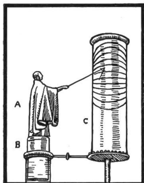
**Wasseruhr mit Zeiger.** Sie trug statt der Zahnräder eine kleine Figur A auf dem Schwimmkolben B, die mit einem Stabe auf den Zylinder C hinwies, welcher die Zeiteinteilung trug. Der aufsteigende Kolben drehte durch ein Zahnräder den Zylinder einmal im Jahre herum; dadurch war im Sommer die breitere, im Winter die schmälere Seite der Stundenringe zu sehen und die Uhr den versch. Tageslängen angepasst.
