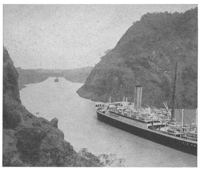
Schiffe auf der Fahrt durch den Panamakanal. Auf dieser Strecke musste ein Bergzug tief eingeschnitten werden. Infolge des losen Gesteins ereigneten sich beim Bau oft grosse Nachrutschungen.
