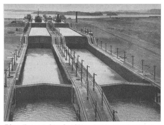
Eine Treppe für Schiffe. Schleusenkammern, in denen die Schiffe stufenweise von der Meeresspiegelhöhe des Atlantischen Ozeans nach dem Gatun-Stausee emporgehoben, oder bei entgegengesetzter Fahrtrichtung gesenkt werden.
