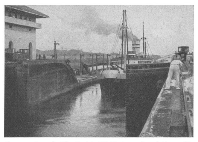
Panamakanal. Ein Frachtschiff fährt aus einer Schleuse. Die kleinen aber starken Elektro-Lokomotiven, "mulas" (Esel) genannt, haben nur die Aufgabe, das Schiff in Linie zu halten, damit Zusammenstösse mit den Schleusenwänden und Toren vermieden werden.
