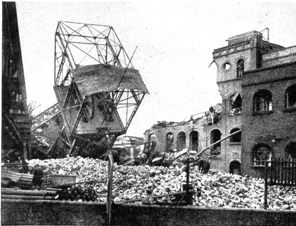
Verheerende Wirkung einer Schlagwetter-Explosion in einer Kohlen-grube. Selbst über der Mine gelegene Gebäulichkeiten sind zerstört worden; der Maschinenturm über dem Aufzugsschacht ist umgestürzt.
