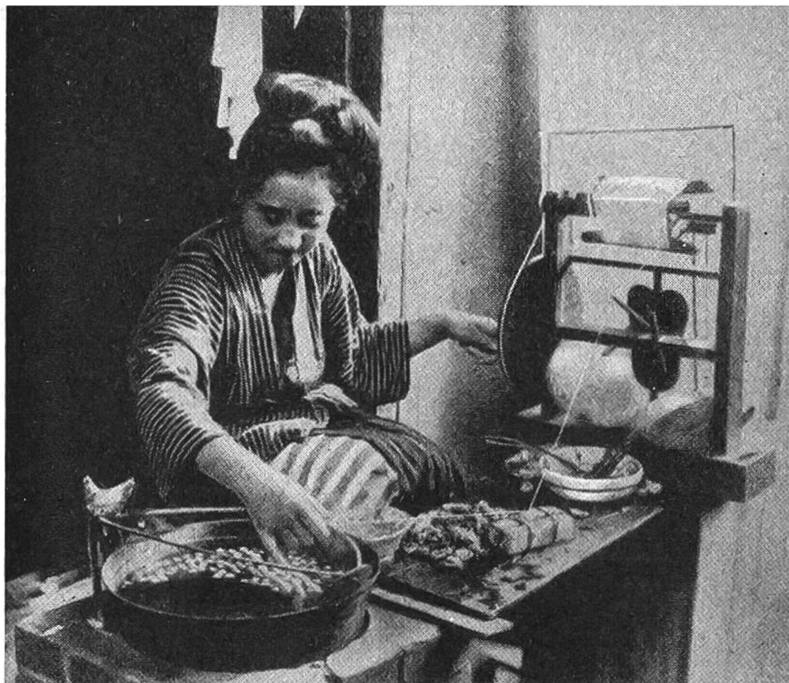
Japanerin beim Seidenspinnen. Nach dem Aufweichen und Bürsten der Kokons in heissem Wasser werden die Fäden mehrerer Kokons zusammengefasst und auf einen hölzernen Haspel aufgewunden.
