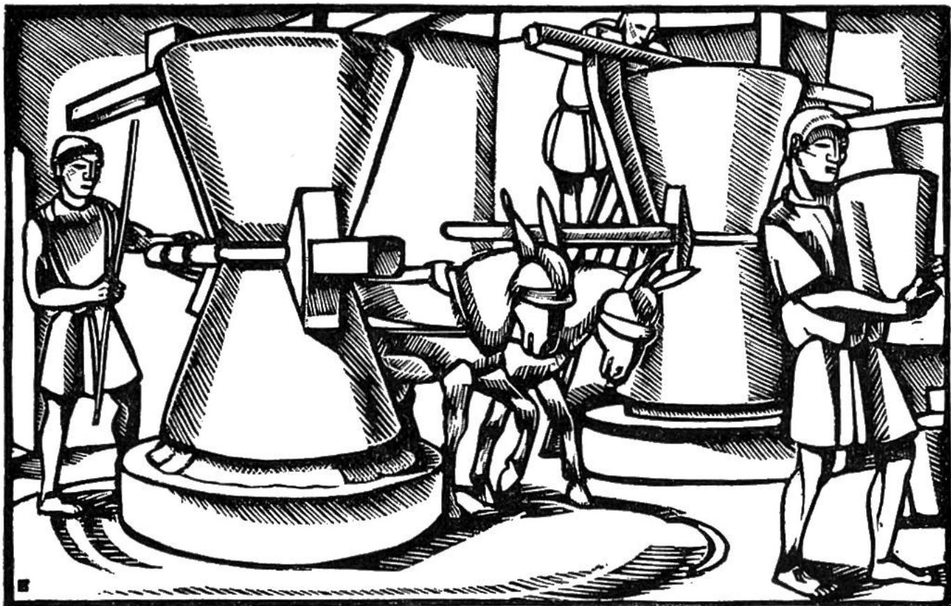
**Römische Getreidemühlen** fand man beim Ausgraben der 79 n. Chr. verschütteten Stadt Pompeji (Bild). Die schweren Mahlsteine wurden durch Tierkraft bewegt. Dies bedeutete einen grossen Fortschritt gegenüber der während Jahrtausenden gebräuchlichen Art, die Getreidekörner von Hand zwischen zwei Steinen zu zerquetschen. An Orten mit Wassergefälle entstanden Wassermühlen (1. Jh. v. Chr. älteste bekannte) u. in Europa Windmühlen, seit 11. Jh.
