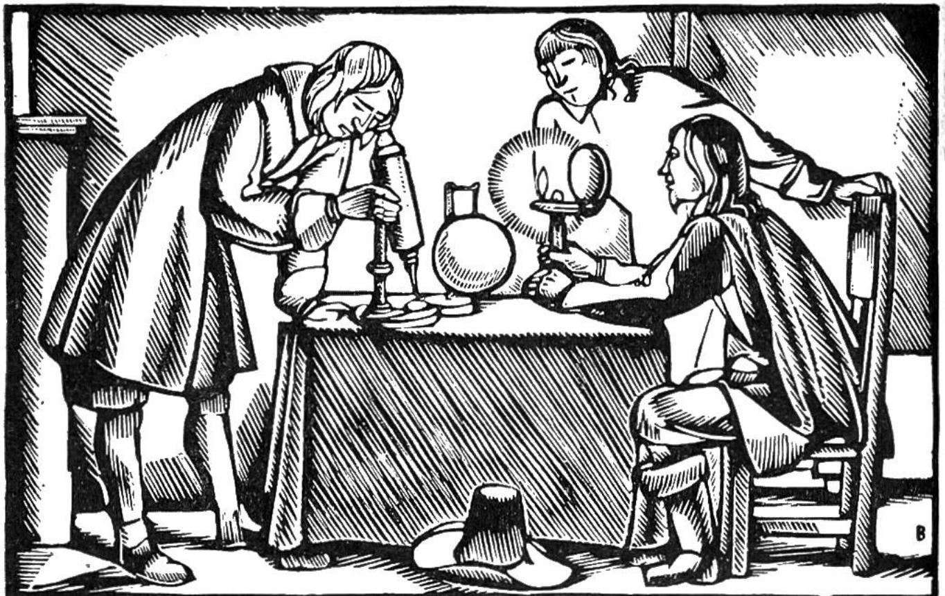
Das **Mikroskop** wurde 1590 vom holländ. Brillenmacher Janssen erfunden und später durch Galilei, Newton, Hertel, Euler u. a. verbessert. (Bild: Mikroskop von Hooke, 1665, mit Beleuchtungsapparat.) Das 1903 erfundene Ultra - Mikroskop vergrössert 2000-fach, während das neueste Übermikroskop mit Hilfe von Elektronenstrahlen millionstel mm sichtbar macht. Fast alle Zweige wissenschaftl. Forschung verdanken dem Mikroskop unschätzbar wichtige Erkenntnisse.
