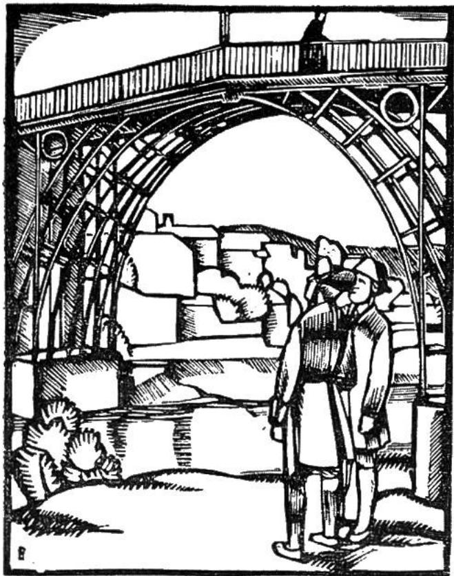
Die erste **eiserne Brücke** der Welt wurde 1779 mit 32 m Weite über den Severn bei Coalbrookdale in England gebaut (Bild); sie steht noch heute. Die Brücke ist aus Gusseisen. Infolge der Erfindung des Walzprozesses (1820) konnte Schmiedeeisen auch zu Bauzwecken z. B. für weitgespannte Balkenbrücken verwendet werden. Die von R. Stephenson, dem Sohn des berühmten Eisenbahnerbauers, 1846—50 erstellte, 464 m lange Britannia-Eisenbahnbrücke war vorbildlich auch für Eisenkonstruktionen anderer Art.
