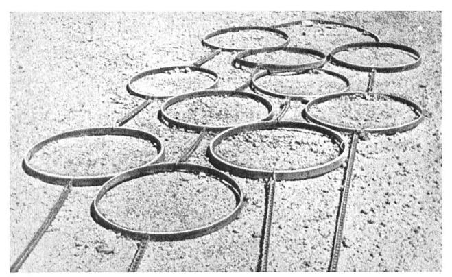
So entsteht die "Lichtstrasse"! Schwere Eisenringe werden mit Ketten zusammengebunden und einem Lastauto angehängt. Das Auto fährt langsam durch die Wüste, und die Ringe markieren den Weg.
