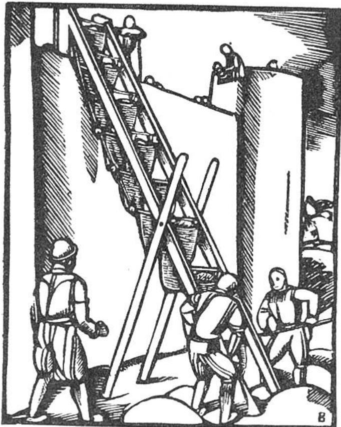
Bei dem Eimerkettenbagger aus dem Jahre 1565 (Bild) werfen Arbeiter die Erde noch mit Schaufeln in die Eimer. Doch die Maschine war ein vorzügliches Hilfsmittel beim Bau von Stadtmauern, Häusern usw. Sie bedeutete einen grossartigen Fortschritt; die Arbeiter brauchten die Baumaterialien nicht mehr auf dem Buckel die Leitern hinauf zu schleppen. Ohne die modernen Eimerkettenbagger, die riesige Mengen von Erdmassen auszuheben vermögen, wären zahlreiche Industrien lahmgelegt.
