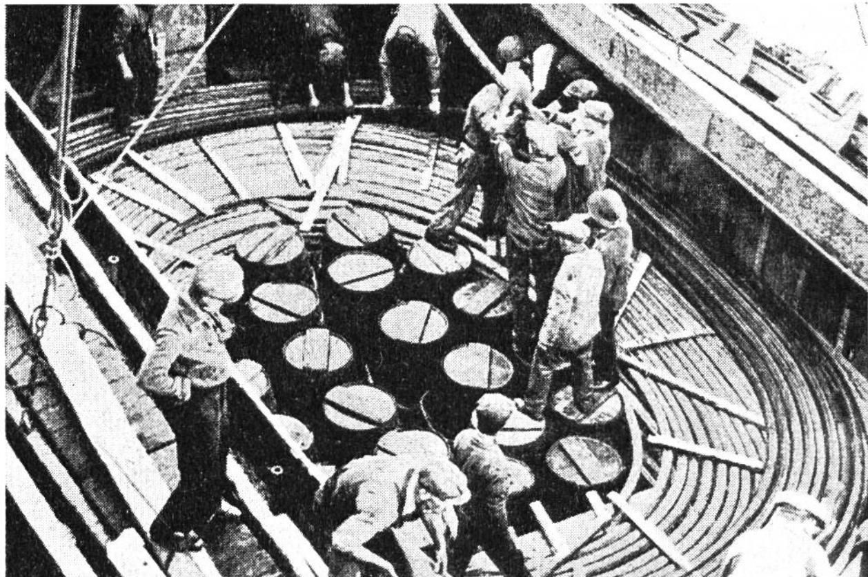
Das Tiefseekabel wird eingeholt. Meter um Meter läuft es über die Rolle am Heck des Schiffes, von kräftigen Fäusten in den eigens dafür gebauten Schiffsrumpholzen gezogen, wo es sorgfältig verstaut wird.
