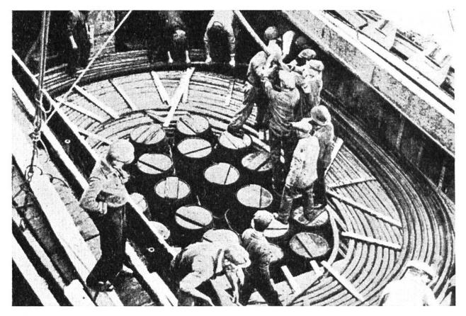
Das Tiefseekabel wird eingeholt. Meter um Meter läuft es über die Rolle am Heck des Schiffes, von kräftigen Fäusten in den eigens dafür gebauten Schiffsrumpf gezogen, wo es sorgfältig verstaut wird.
