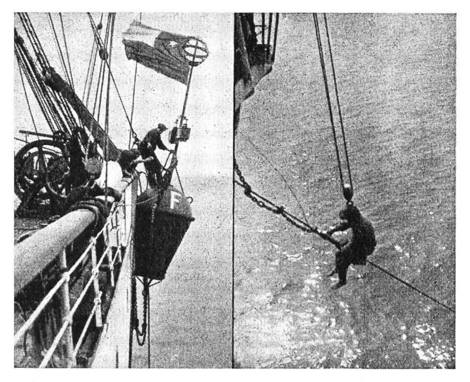
Ein Tiefseekabel wird repariert. Links: Eine Markierungsboje bezeichnet die Stelle, wo eine Störung vermutet wird. Rechts: Das emporgezogene Kabel wird beidseits angekettet und dann entzweigeschnitten. Die beiden Kabelenden werden im elektrischen Prüfstand des Schiffes untersucht.
