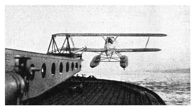
Das Flugzeug kurz nach dem Abschleudern durch den sogenannten Katapult, wodurch das Flugzeug innert 1½ Sekunden eine Geschwindigkeit von 105 Stundenkilometer erreicht hat. Vor dem linken Flügel ist der "Schlitten" zu sehen, auf dem die Flugmaschine ruhte.
