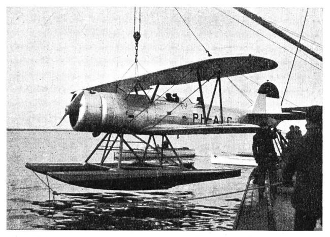
Ein Flugzeug, das auf dem Meer niedergegangen ist, wird an Bord des Katapultschiffes gehoben. Sobald der Brennstoff nachgefüllt ist, kann es seine Fahrt fortsetzen.
