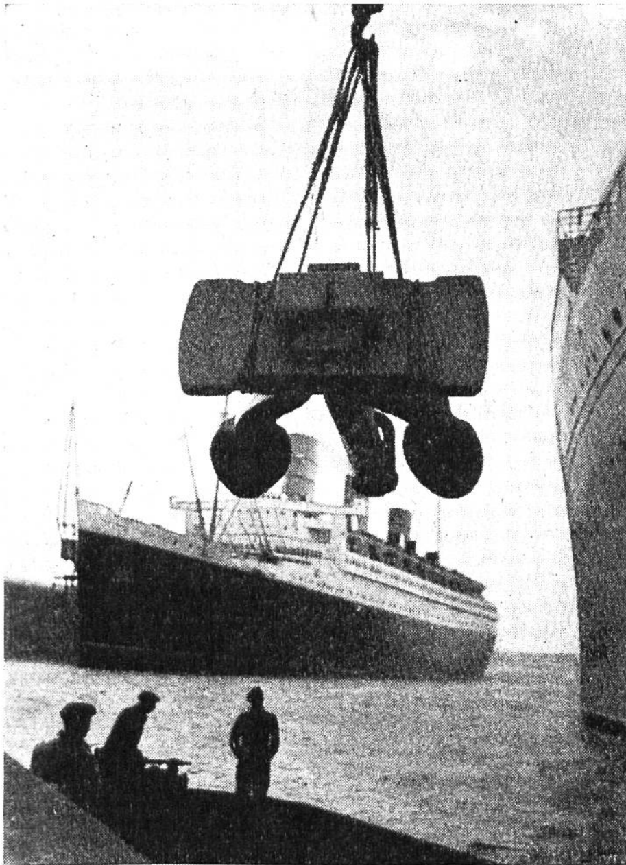
Der neue Anker für den englischen Dampfer „Queen Mary“ wiegt nicht weniger als 14 000 kg. Der Arm des befördernden Riesenkrans reicht bis zu dem im Hintergrunde liegenden Schiff.
