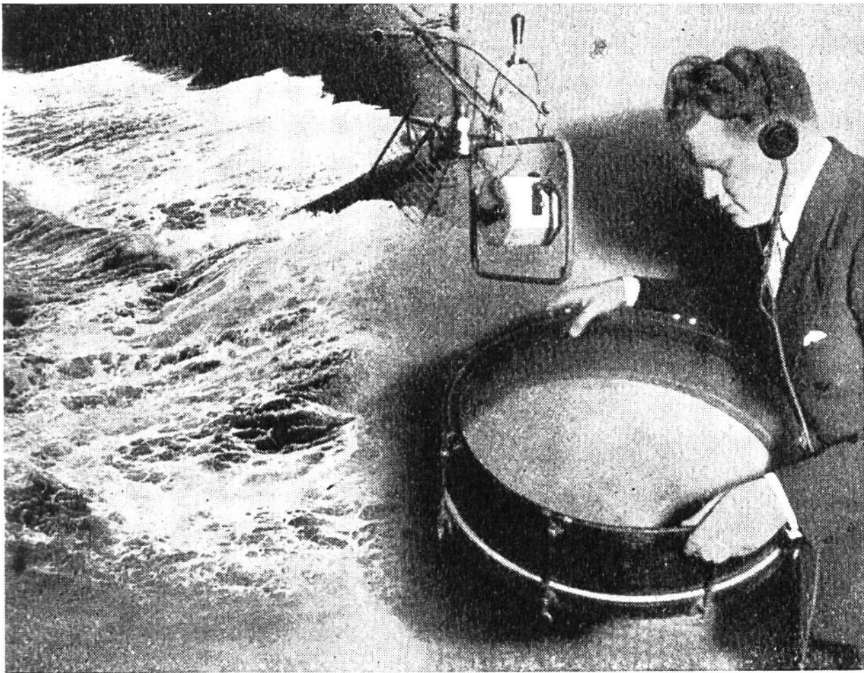
Meeresbrandung vor dem Mikrophon: eine gewöhnliche Trommel, deren Boden mit Bleischrot bedeckt ist, wird sanft geschaukelt .... und der Hörer lauscht dem an- und abschwellenden Tosen der Wellen.
