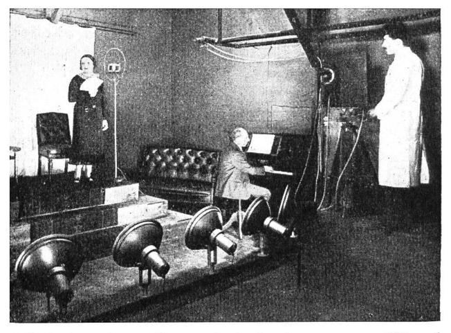
Blick in einen Fernseh-Aufnahmeraum. Während Musik und Gesang durch das übliche Radiomikrophon zur Übertragung gelangen, wird das Bild der Sängerin durch einen besondern Fernseh-Aufnahmeapparat eingefangen.
