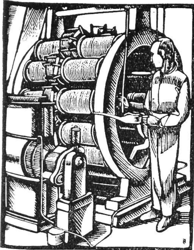
**Die Dynamomaschine** von Siemens, 1867, war die erste praktisch brauchbare Einrichtung zur Erzeugung elektr. Stromes auf elektro-magnetischem Weg. Siemens hatte entdeckt, dass sich Strom u. Magnetismus gegenseitig verstärken; er nannte diese Eigenschaft „Dynamoprinzip“ und baute, hierauf gestützt, die Dynamomaschine. Sie wurde der Ausgangspunkt für die grossartige Entwicklung der Starkstromindustrie. Wichtige Verbesserungen: 1869 Ringanker, 1887 Drehstrommotor von Tesla.
