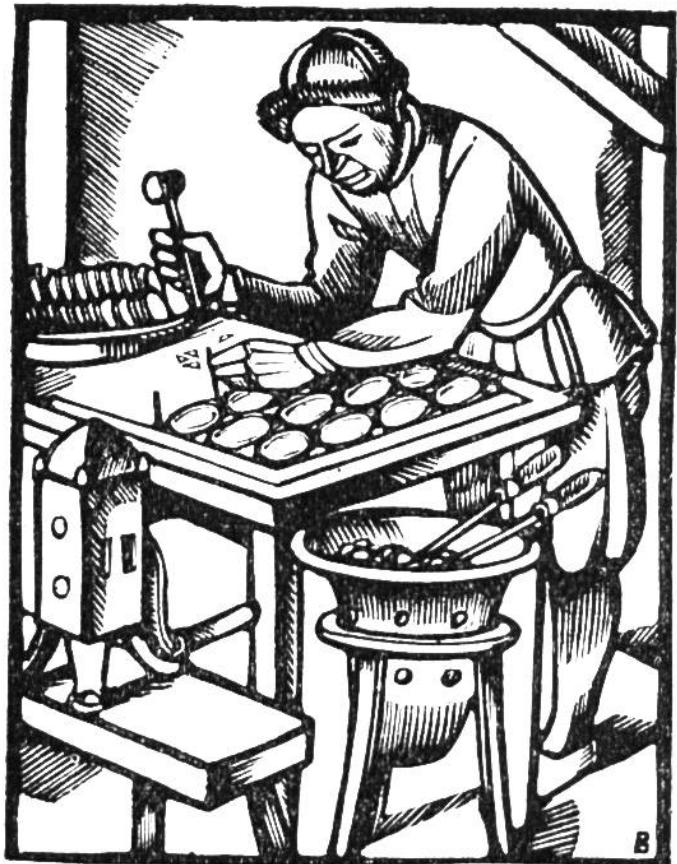
**Glaser** bei der Herstellung von Butzenscheiben, um 1550. Die Kenntnis von der hochstehenden Glasindustrie des Altertums ging später verloren; vom frühen Mittelalter an entwickelte sich dann die Glasbläserei von neuem. Vom einfachen Fensterglas gelangte man zur Herstellung von Kunstgläsern, deren Vollkommenheit in Form und Material seither nicht mehr erreicht wurde. Venezianische und böhmische Gläser aus dem 16. und 17. Jahrhundert sind heutzutage gesuchte Kostbarkeiten.
