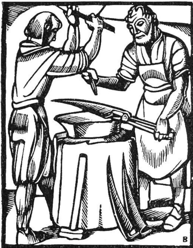
**Sensenschmied** an der Arbeit. Schon die keltischen Ureinwohner der Schweiz benützten vor über 2000 Jahren Sensen, deren Schneide aus Eisen verfertigt war. Sonderbarerweise kam das praktische Gerät in Vergessenheit und tauchte erst um 1550 wieder auf. — Die Sense ist aus der Sichel entstanden, die bereits bei den Menschen der Steinzeit, den ersten Ackerbauern, in Gebrauch war. Dieses Feuersteingerät gehört zu den ältesten und wichtigsten Zeugen vorgeschichtlicher Kultur.
