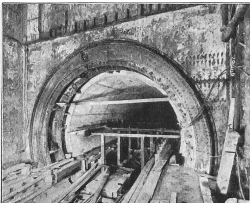
Der Hudson-Tunnel ist weitergediehen. Schon sieht man deutlich die eigentliche Fahrbahn. Sie wird umfasst von stützenden Ringen aus Stahl, die einen Durchmesser von etwa 10 m aufweisen.
